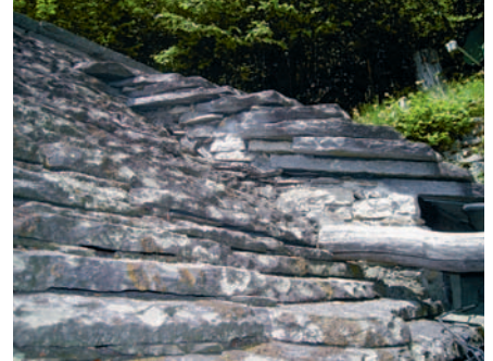
Das Pendant: Granitdach aus beschlagenen und geschnittenen Granitplatten – teuer im Bau, dafür dicht und praktisch unterhaltsfrei.
